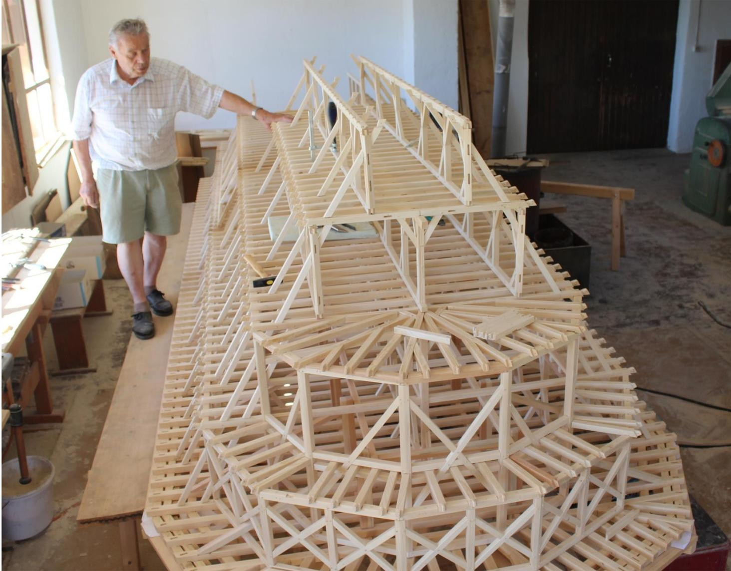
Im Bauabschnitt 1 sind die oberen Kehlbalckenlagen aufgerichtet. Die ersten Sparren können eingepasst werden.
