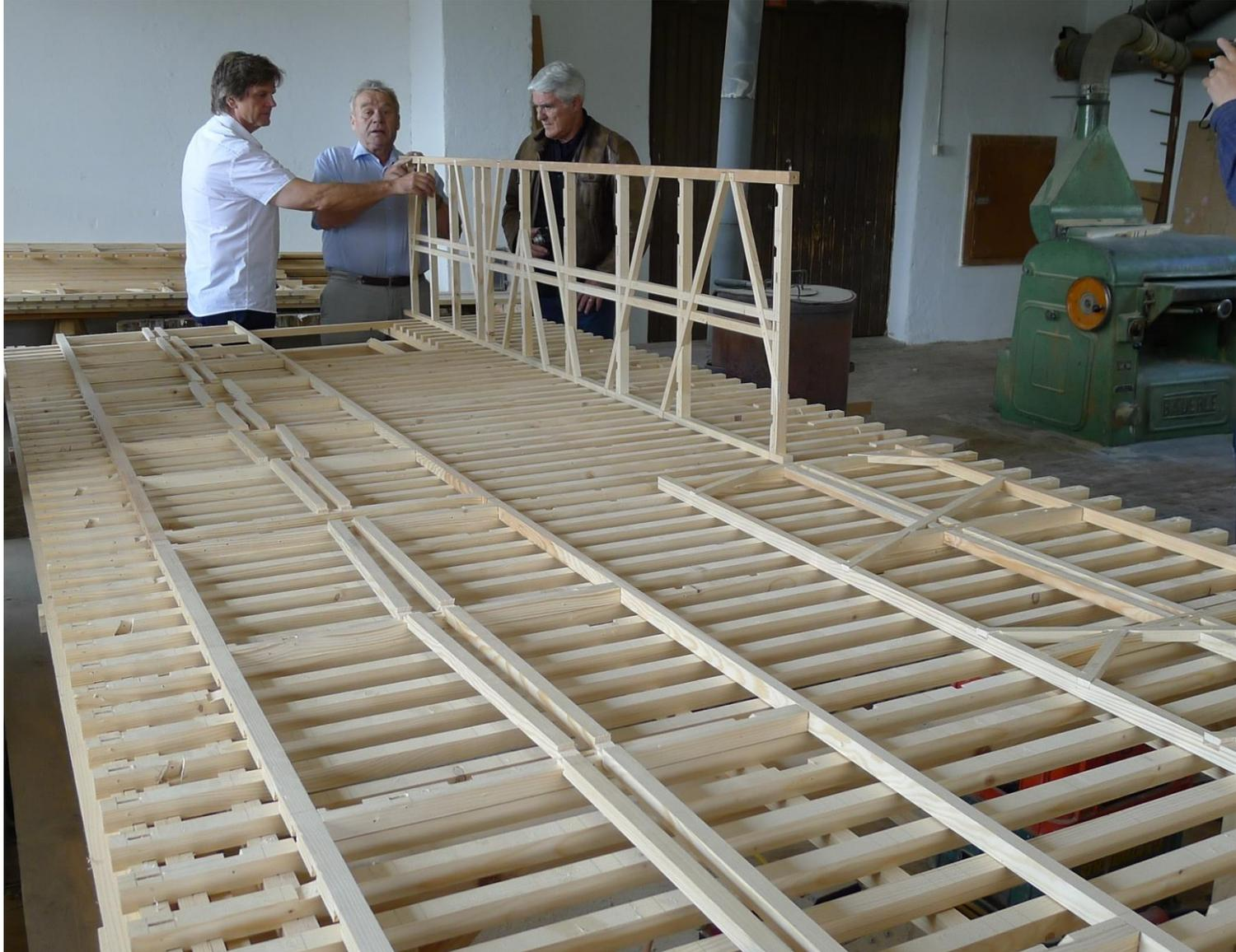
Die erste Kehlbalckenlage ist auf den Längsverband aufgekämmt.
