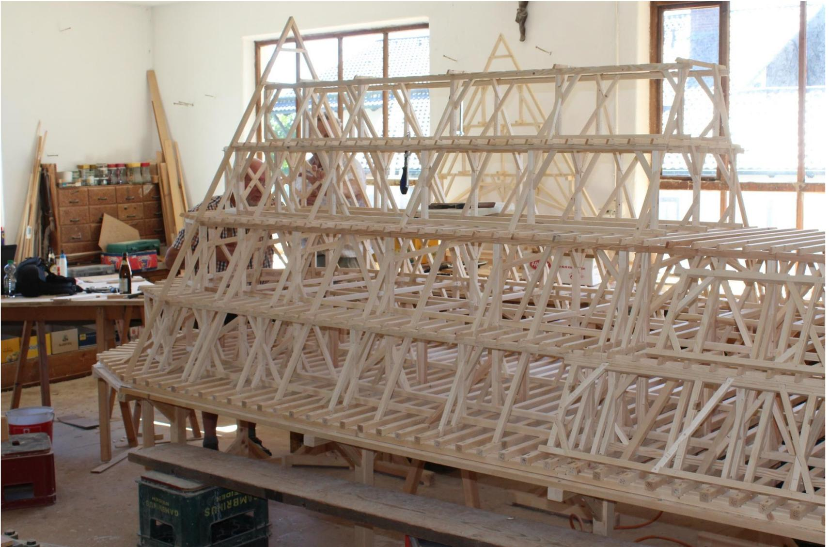
Die Sparrenlage im Bauabschnitt 1 ist fertig.
