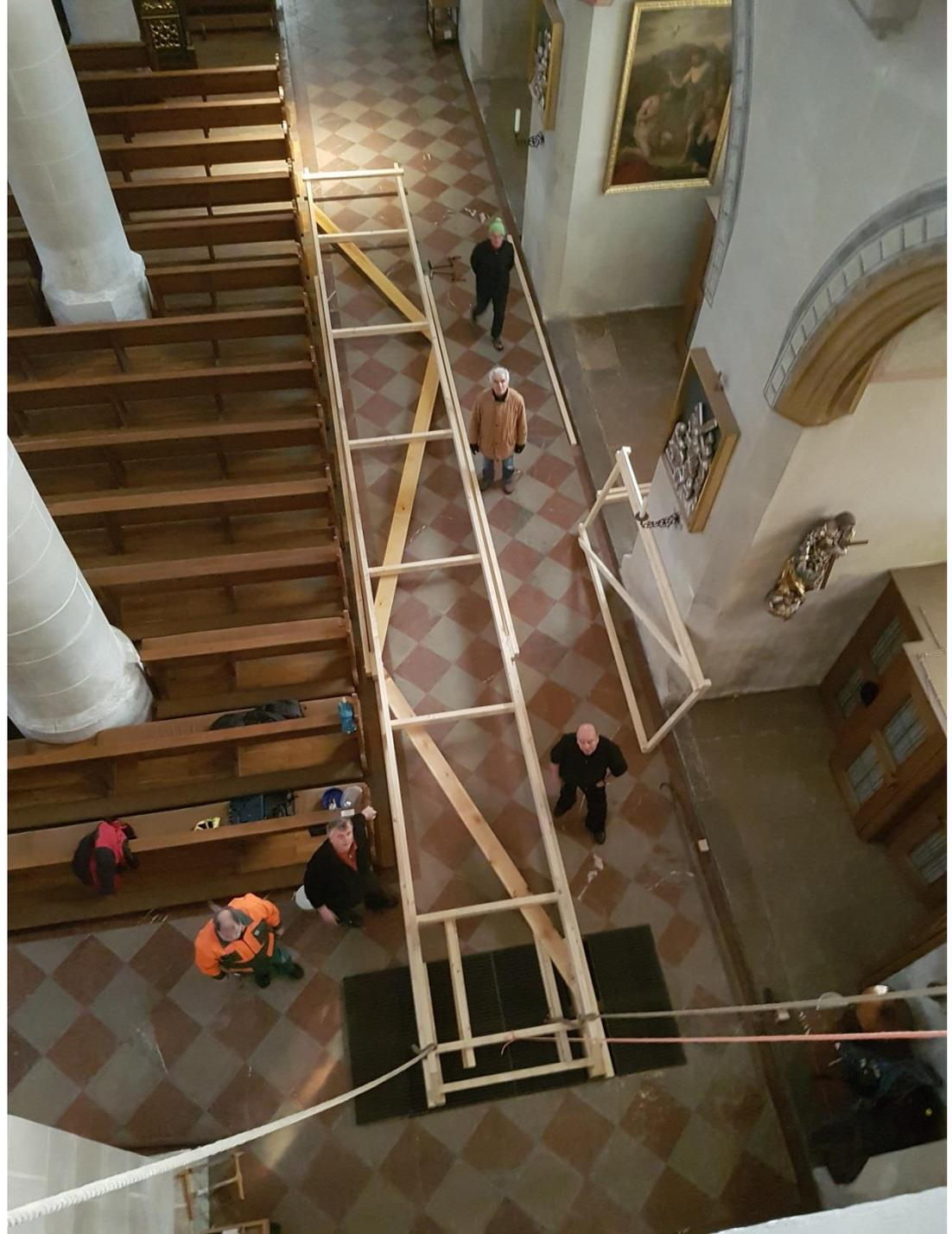
Die Rampe steht und ist mit Streben abgestützt.
